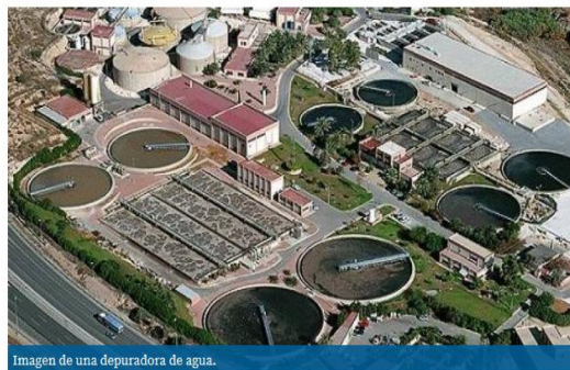
Imagen de una depuradora de agua.
